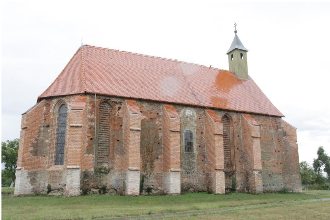
Sl. 401. Crkva Sv. Luke, Lipovac, sjeverno pročelje, svetište.
