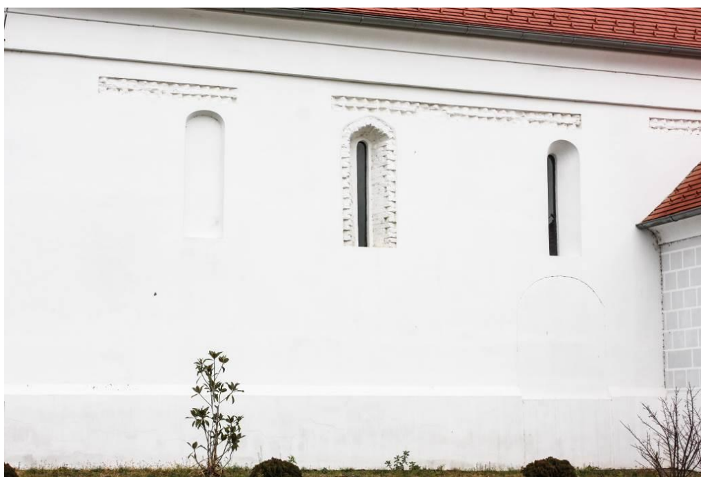
Sl. 269. Reformatorska crkva, Kneževi Vinogradi, južno pročelje broda crkve (II. graditeljski sloj)
