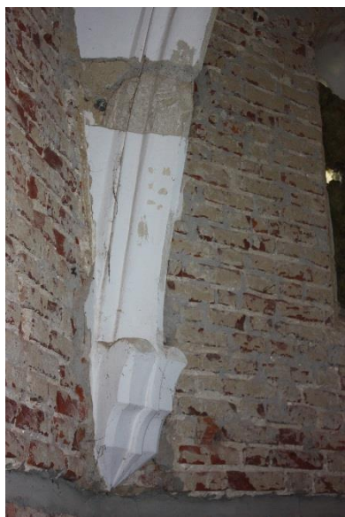
Sl. 315 i 316. Svodno rebro u svetištu crkve (snimak rebra: Horvat, Z., „Neke profilacije“, 7)
