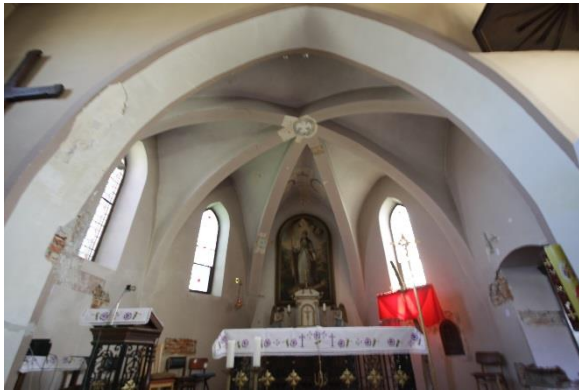
Sl. 326 i 327. Crkva sv. Grgura, Šljivoševci, svod i trag otklesane konzole svoda (desno).
