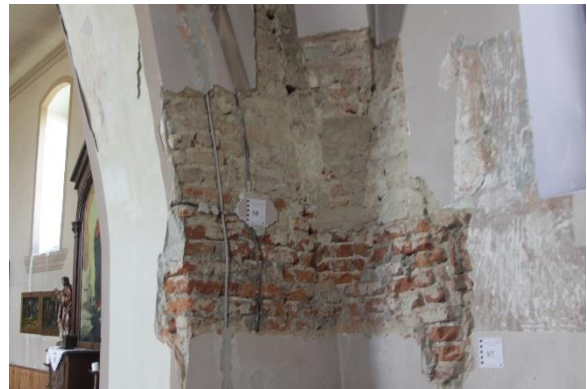
Sl. 326 i 327. Crkva sv. Grgura, Šljivoševci, svod i trag otklesane konzole svoda (desno).
