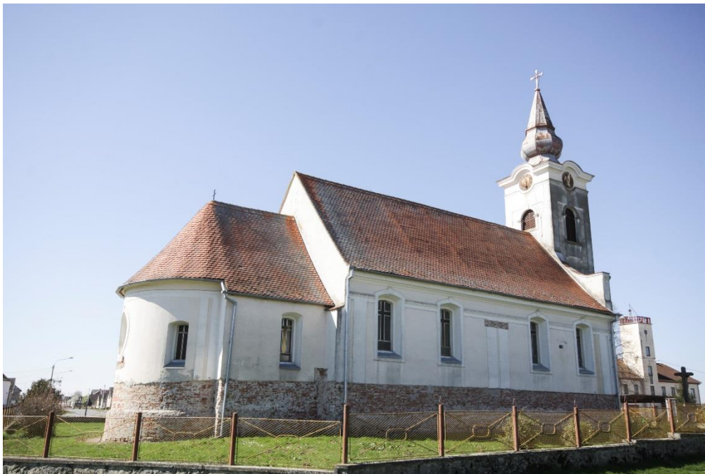
Sl. 320. Crkva sv. Petra i Pavla, Marijanci, sjeveroistočno pročelje.
